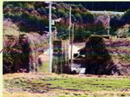
3 : 旧船木鉄道鉄橋跡
